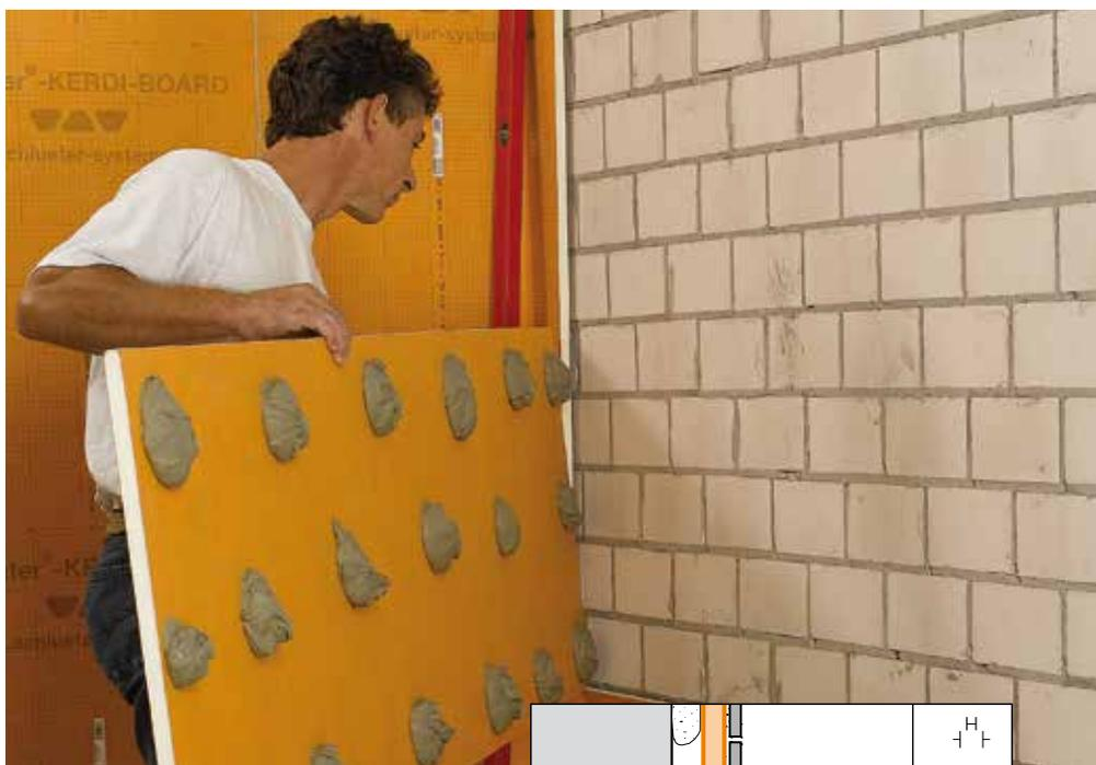
gerundeten Trennwänden, zur Verkleidung von Vorwandinstallationen und Rohren (Rohrkästen), zum Verkleiden von geraden oder gerundeten Wannen und Duschen, zum Herstellen von Küchenarbeitsplatten, Waschtischen, Ablagefächern oder sonstigen Badmöbeln. Ebenso eignet es sich zum Herstellen von ebenflächigen Untergründen im Bodenbereich bei Sanierungsarbeiten in durch Personen belasteten Sanitärbereichen oder dergleichen.
