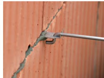
Zweiteiliger Wienerberger Luftschichtanker (WB-LSA) im Einbauzustand.
