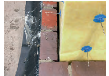
Zweiteiliger Wienerberger Luftschichtanker (WB-LSA) im Einbauzustand.
