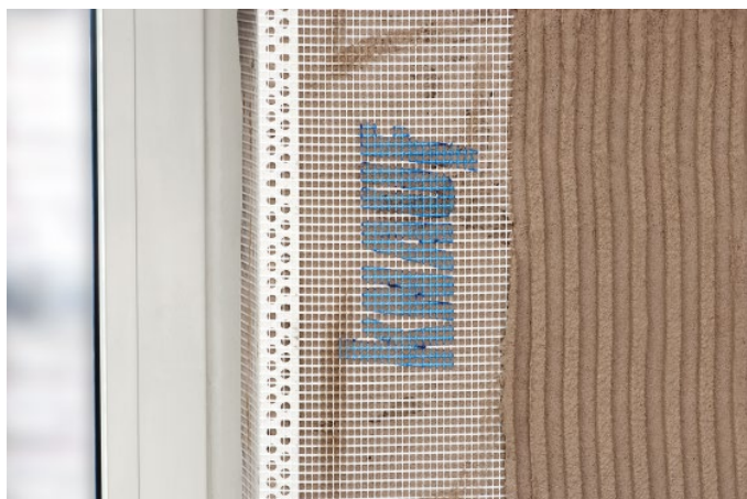
Bild 16: Anputzprofile
