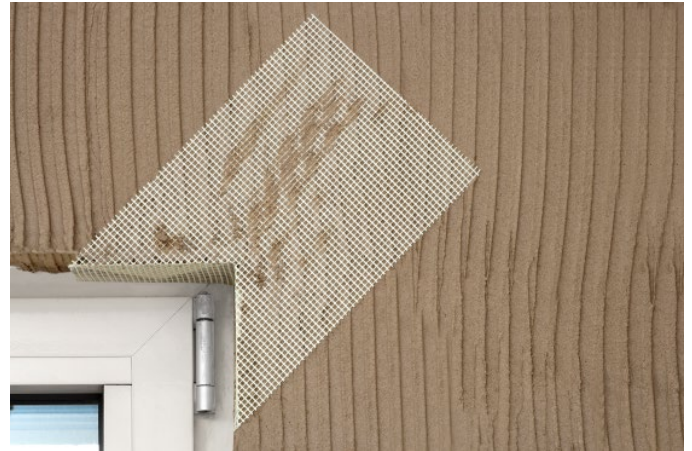
Bild 14: Ausbilden von Wandöffnungen
