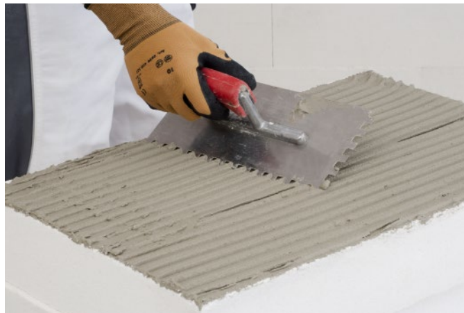
Bild 3: Klebemörtel auftragen
