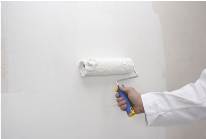
Bild 13: Schlussbeschichtung
