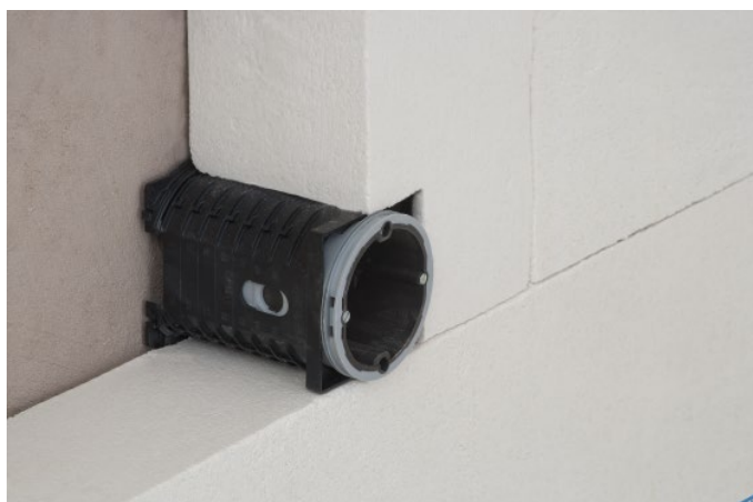
Bild 17: Einbau von Elektrodosen
