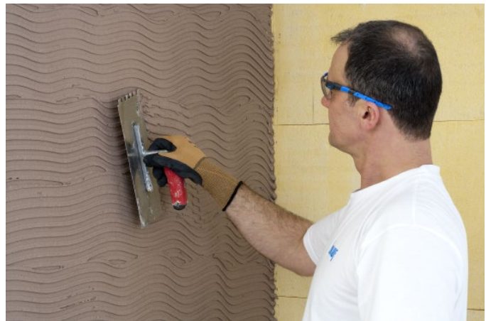
Bild 10: Armierschicht auftragen
