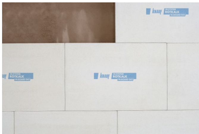
Bild 4: Plattenverlegung in Fläche
