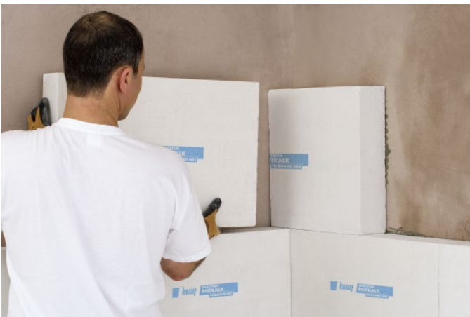
Bild 6: Plattenverlegung im Eckbereich
