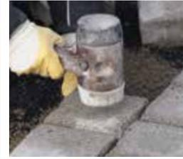
**Betonpflaster hammerfest setzen, Frisch-in-frisch-Verlegung**
